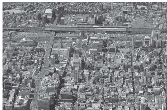
＜上空から見た福島駅前の様子＞
