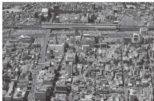
＜上空から見た福島駅前の様子＞
